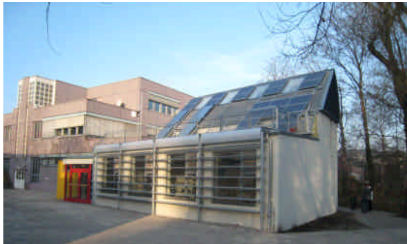
Abbildung 67: Ausbildungspavillon für regenerative Energien und Energiemanagement.
