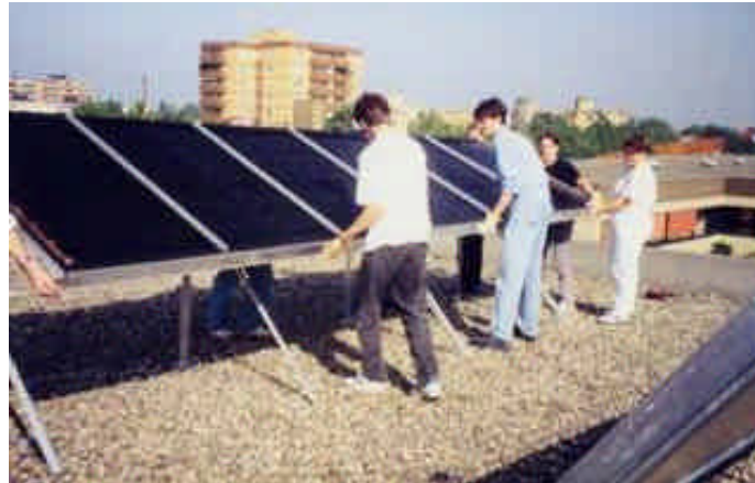
Abbildung 93: Aufbau der Solaranlage an der Schule.
