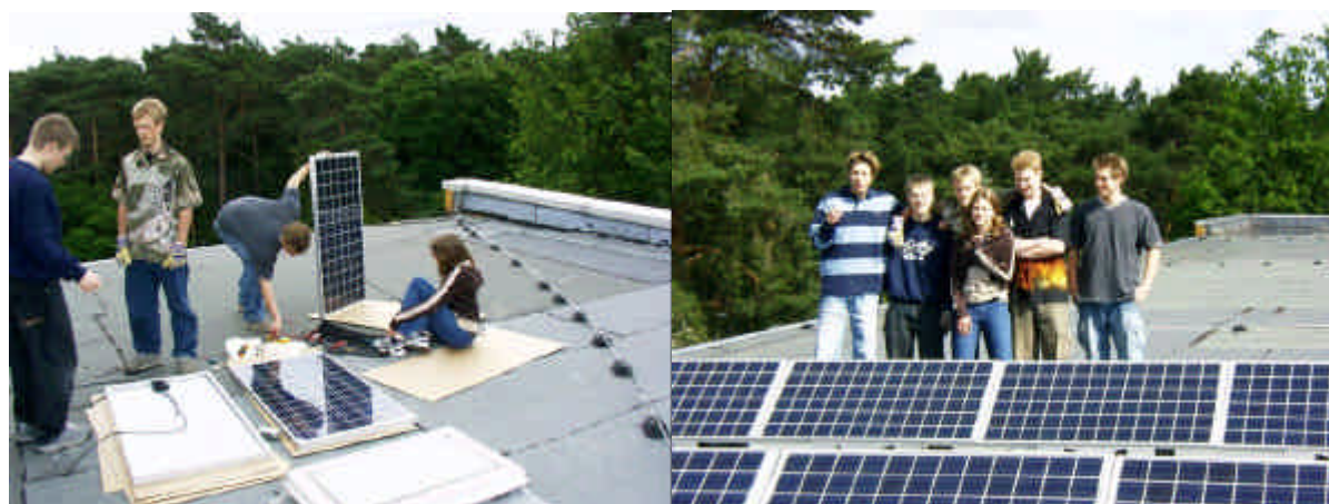
Abbildung 96 und 97: Aufbau der Solaranlage an der Wilma-Rudolph-Oberschule.
