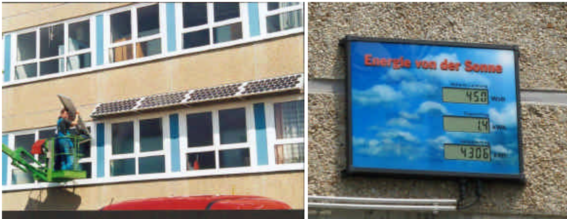
Abbildung 81 und 82: Montage der Photovoltaik-Anlage und die Anzeigentafel der PV-Anlage.
