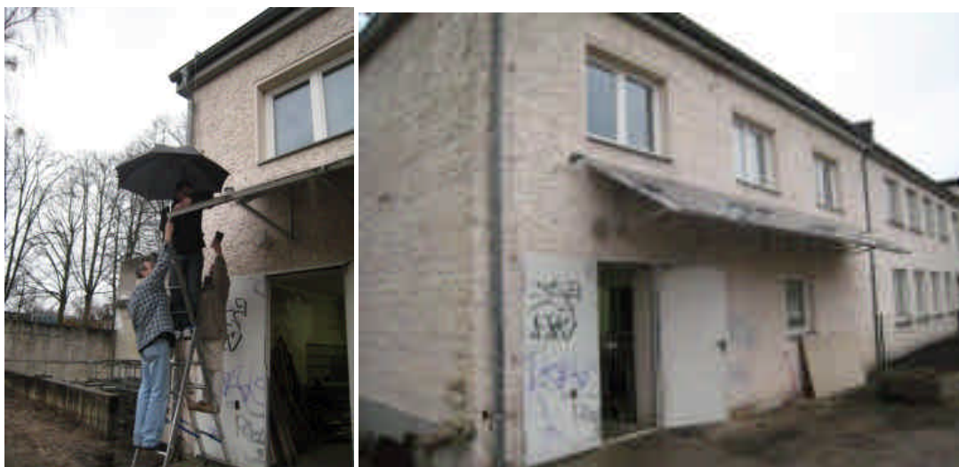
Abbildung 32 und 33: Installation der Sensoren und fertige Anlage.
