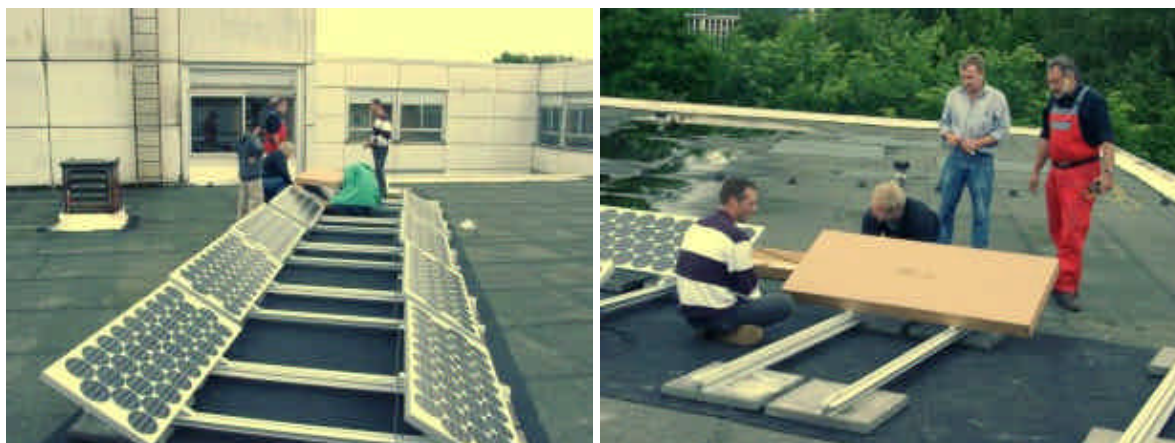
Abbildung 37 und 38: Aufbau der Anlage.
