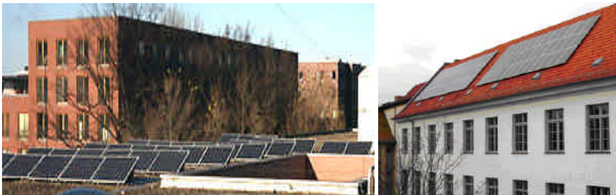
Abbildung 68 und 69: Bürgersolaranlage auf dem OSZ (links) und dem OSZ BWD (rechts).
