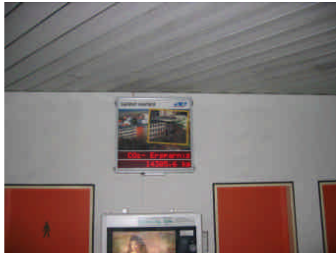
Abbildung 62: Anzeigetafel der Solaranlage.
